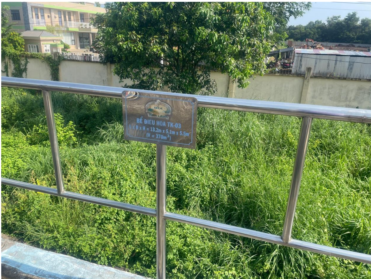
Bể điều hoà
