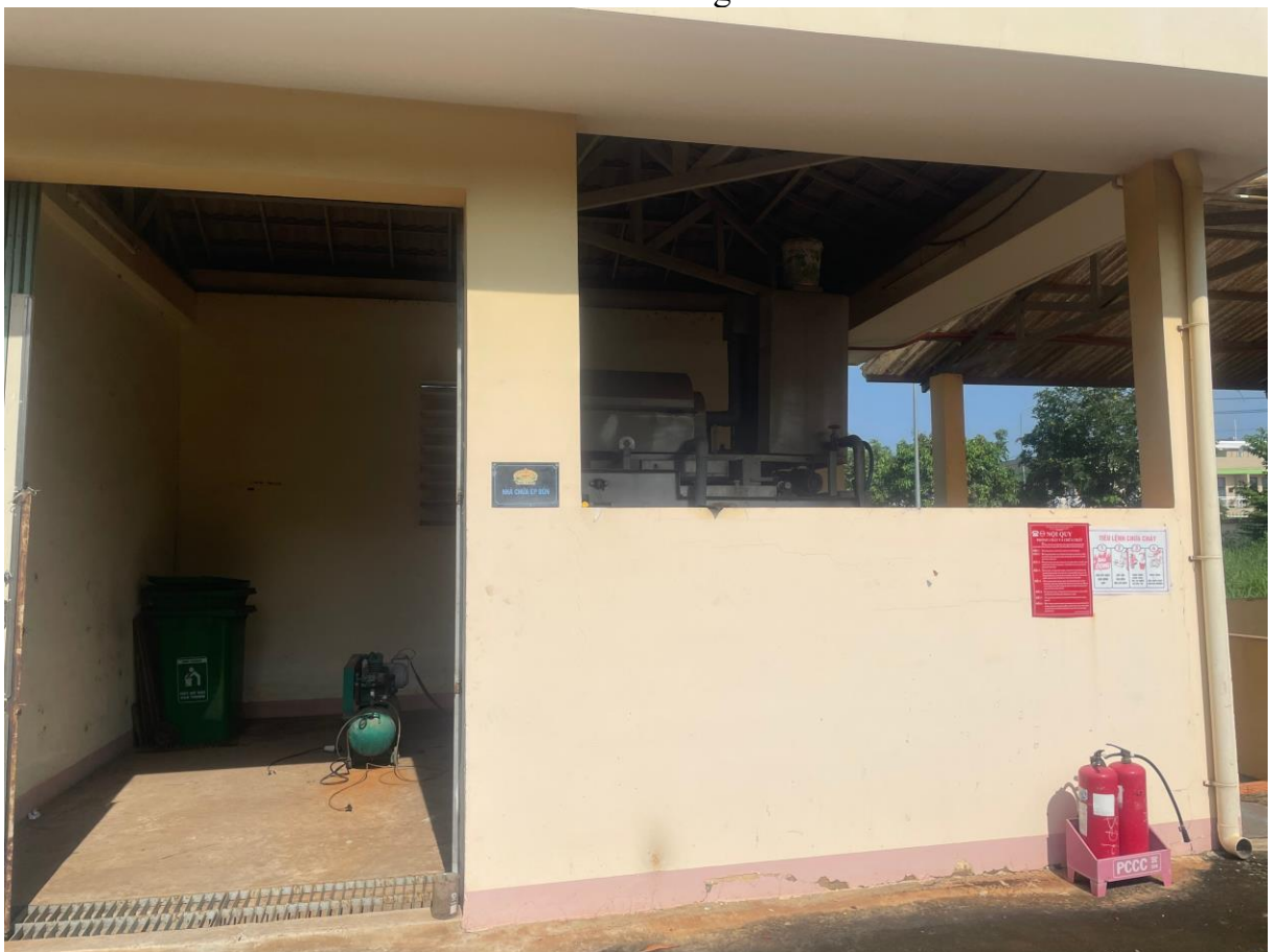
Nhà chứa ép bùn
